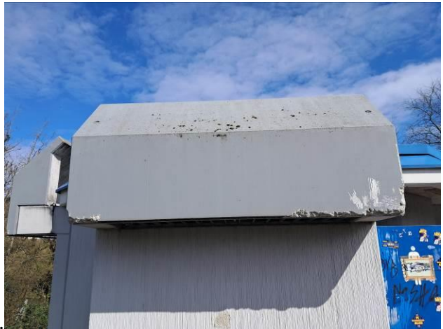
Foto 5: Betonfertigelemente Dach
